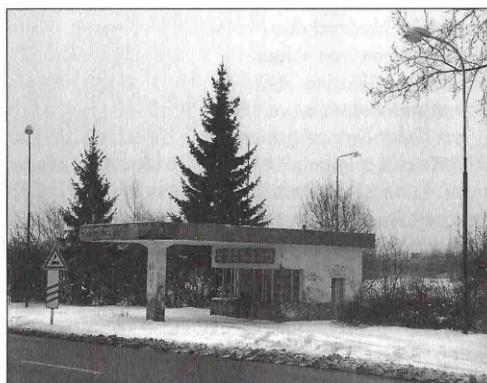
Opuštěná benzinová čerpací stanice v roce 2005
